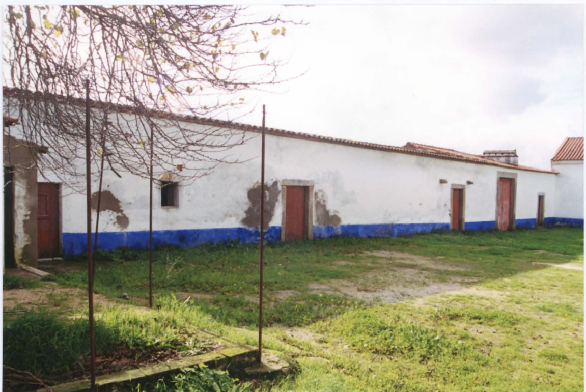
Pateo do Edifício Central
